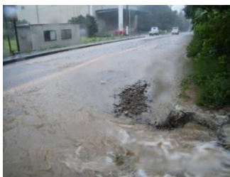
写真：(主)南濃関ヶ原線での土砂流出の状況 ※H25.9.16 台風18号に伴う大雨による被害
