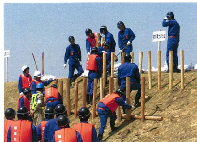
水防演習 Flood drill
