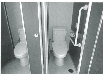
改修されたトイレ
