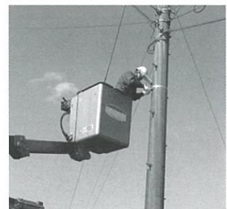
LED交換工事
