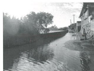
冠水した駒野の市道
