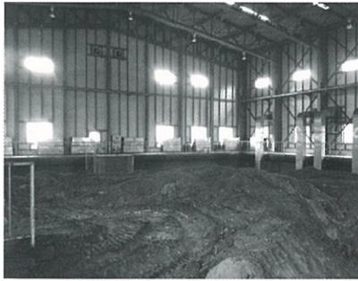
一般廃棄物最終処分場
